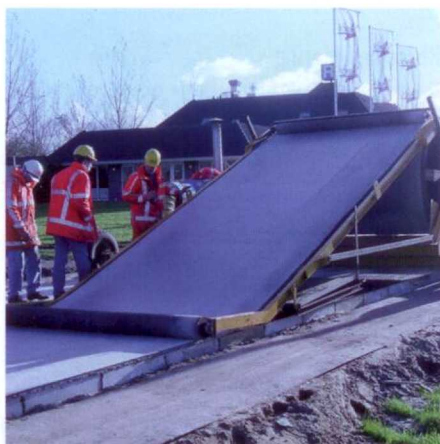
Aanleg van twee van de vier proefvakken: De Uitrolbare Weg (links) en Modieslab (rechts).
