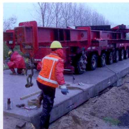
Aanleg van twee van de vier proefvakken: De Uitrolbare Weg (links) en Modieslab (rechts).
